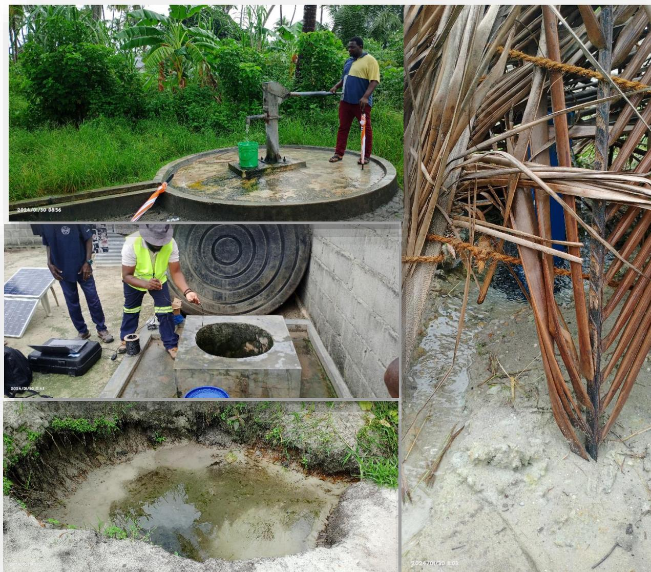
**Foto 3 - Unidades de abastecimento de água na AID do Projecto: a) bomba manual; b) poço manual no B. Quelimane; c) poço manual no B. Bagala; d) água transbordando no furo recém contruído no B. Bagala**
